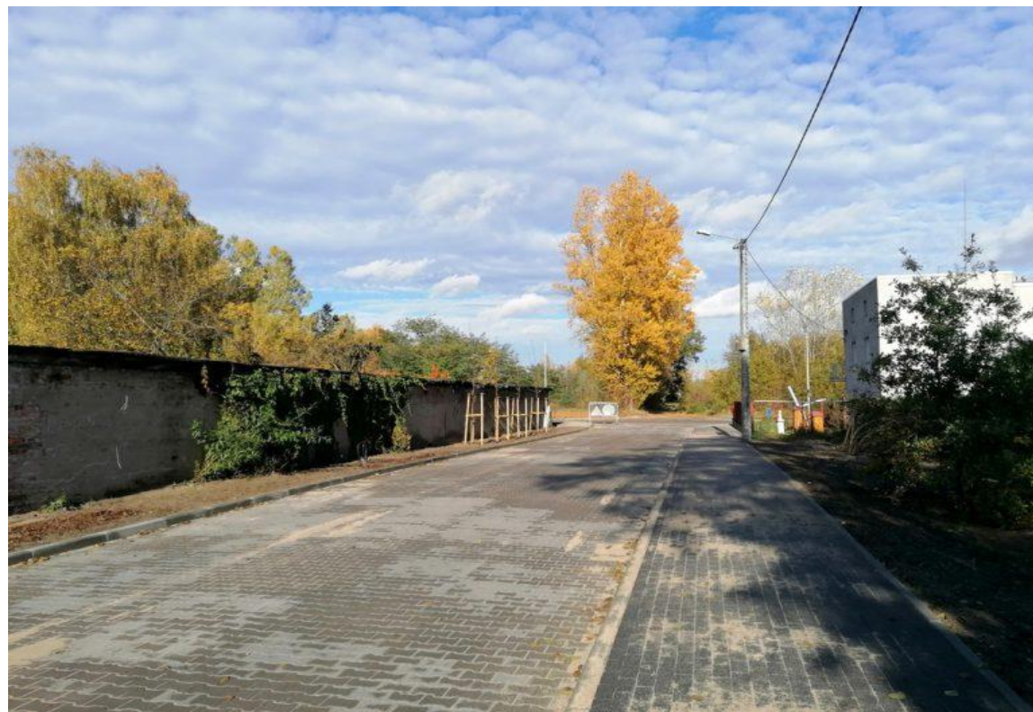
ul. Łokietka po przebudowie
