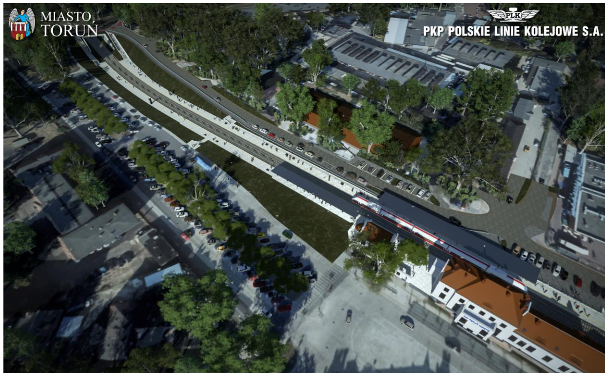
Stacja kolejowa Toruń Miasto MODERNIZACJA LINII KOLEJOWEJ NR 353 NA ODCINKU TORUŃ GŁÓWNY – TORUŃ WSCHODNI WRAZ Z INFRASTRUKTURĄ DWORCOWĄ ORAZ BUDOWĄ NOWYCH PRZYSTANKÓW KOLEJOWYCH W TORUNIU – BIT CITY II
